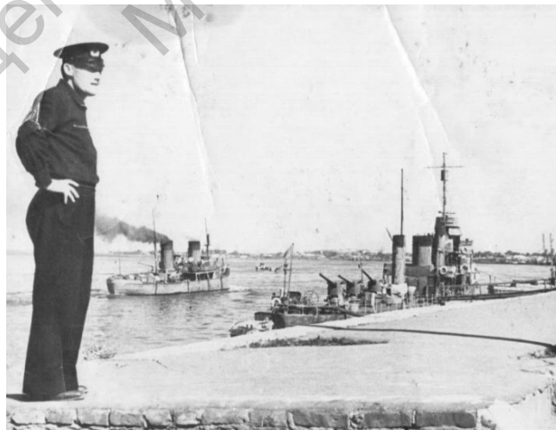
На СЛИП-3. Вид на реку Волгу. Город Астрахань 1961 год.
