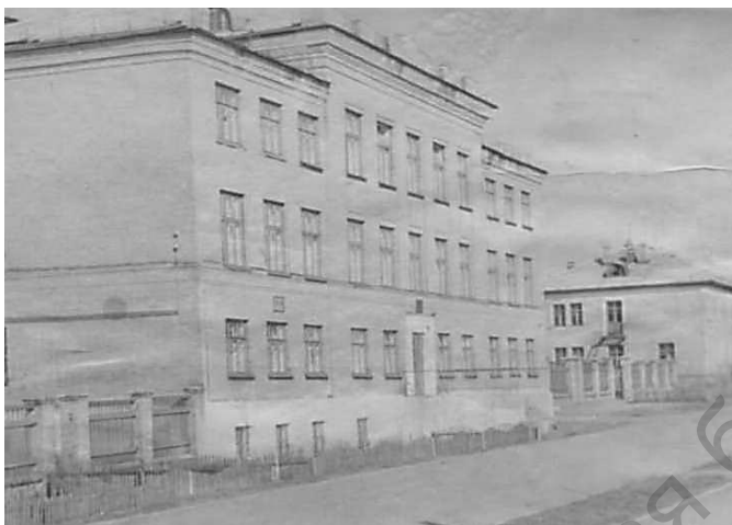
Здание ПТУ-9. Сосногорск, 1972 г.
