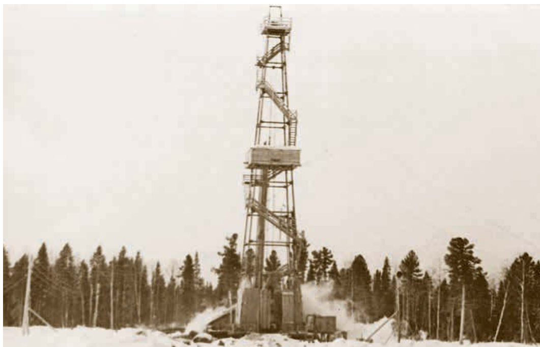
Пашнинское нефтяное месторождение. Буровая № 58. 1963 г.
