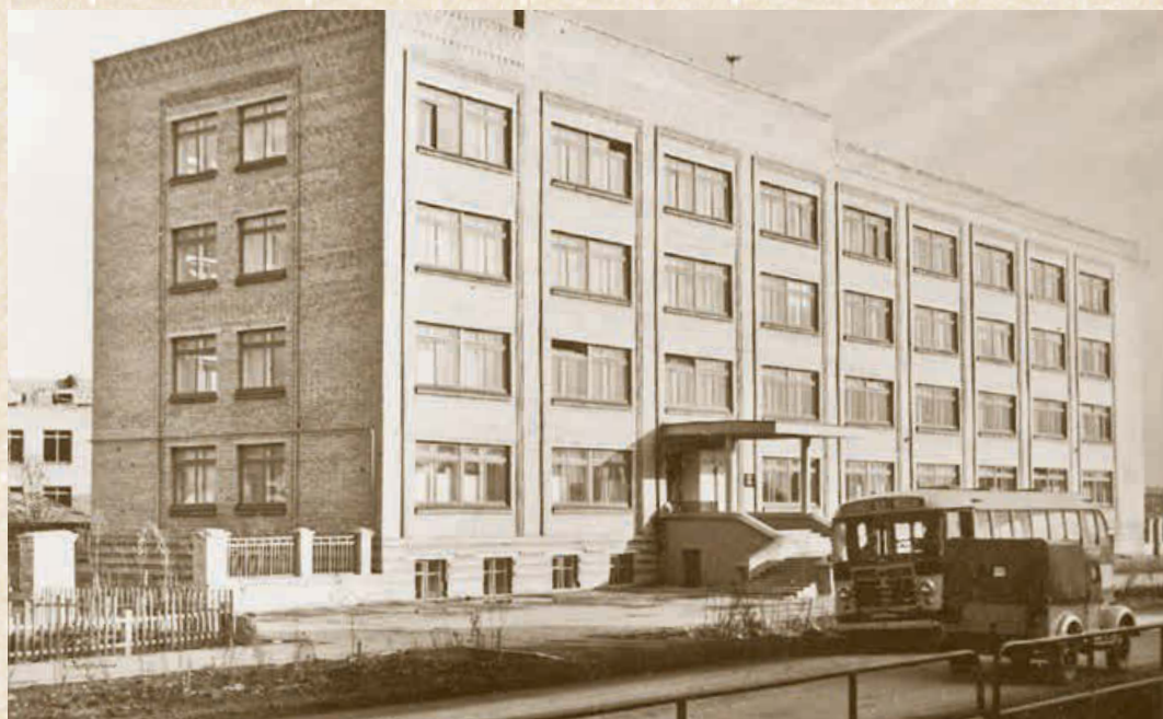
Здание Коми филиала ВНИИГАЗа по улице Севастопольской. Ухта, 1966 г.
