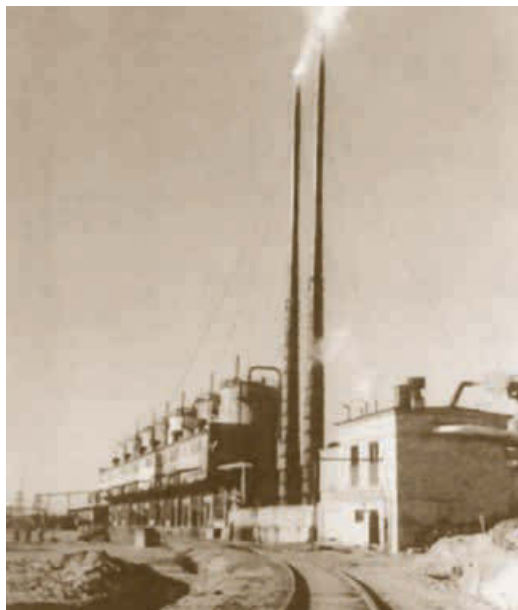
Ухтинский НПЗ. Битумная установка № 1 куба периодического действия, введенная в эксплуатацию в 1952 г.
