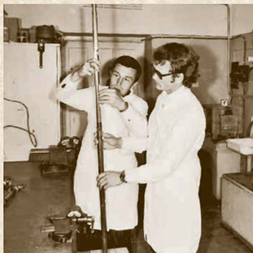
Обслуживание глубинного манометра. Сотрудники лаборатории комплексных исследований пластов и скважин Коми филиала ВНИИГАЗа. А.С. Семёнов (слева), Е.М. Гурленов. Ухта, 1975 г.
