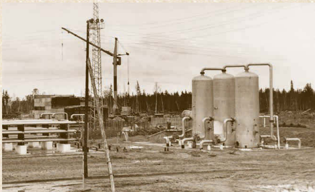
Вуктыльское месторождение. Установка комплексной подготовки газа. Сборный пункт № 1, третья ступень цеха низкотемпературной сепарации. 1970-е гг.
