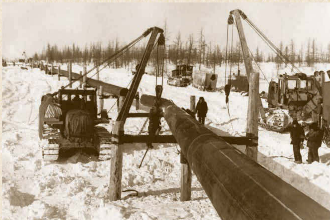
Вуктыль. Строительство трубопровода. 1970-е гг.
