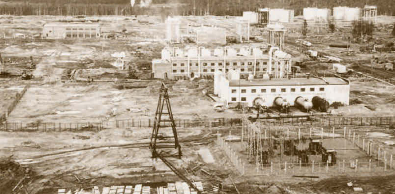
Вуктыльское газоконденсатное месторождение. Установка комплексной подготовки газа. Главные сооружения. 1969 г.
