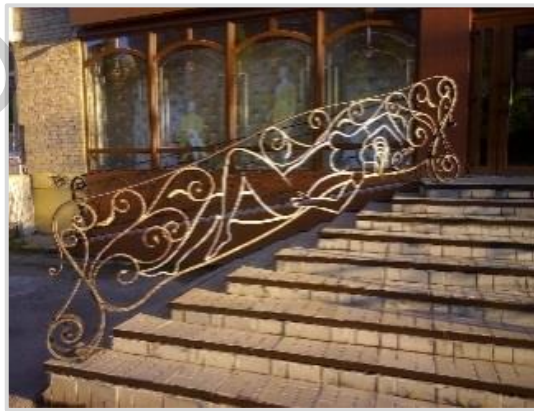
Перила лестничного марша. Кованый металл
