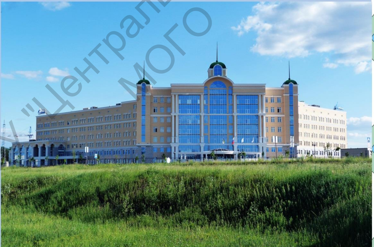
ООО "ГАЗПРОМ ТРАНСГАЗ УХТА" НА БЕРЕГУ р. ЧИБЬЮ
