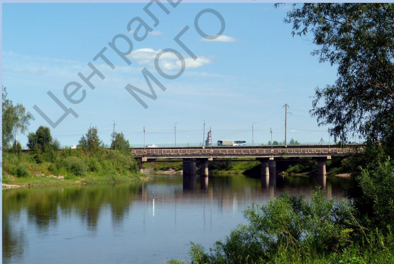
МОСТЫ ЧЕРЕЗ р. УХИТА
