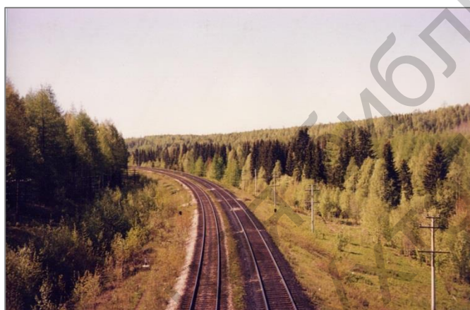
Строительство магистрали «Москва – Воркута» началось в 1937 г., а в декабре 1941 г. первый эшелон из Воркуты отправлен в центр СССР. Фото Л. Тарасова, 2002 г.
