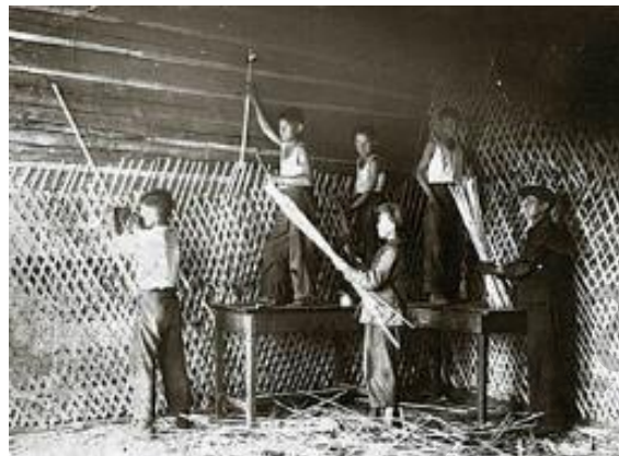
Так набивали дранку на стены внутри здания. Фото из архива А. Н. Козулина
