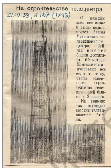
На строительстве телецентра // Ухта. – 1959. – 27 октября. – С. 3. Фото из работы В. Ефимова
