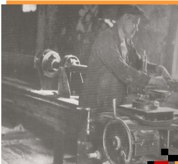
Производство деревянных обсадных труб для нефтешахт Ярегского месторождения
